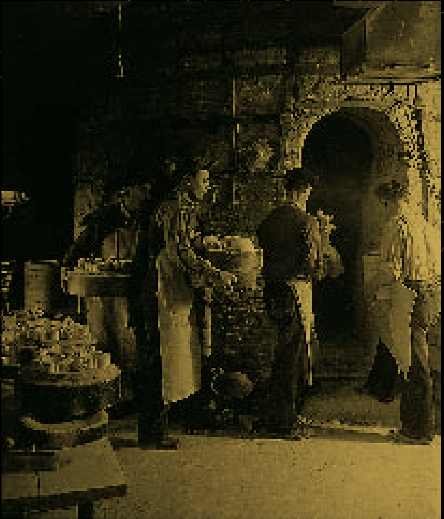
Égetőkemence berakása zsengéléshez, Trum Ferenc égető. Fotó: Vadas Ernő, 1953–54 (Iparművészeti Múzeum adattára)
